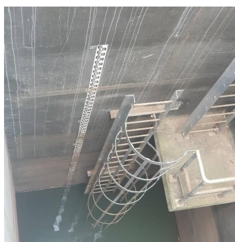
รูปที่ 21 อุปกรณ์แสดงระดับน้ำของแม่น้ำแม่กลองที่บริเวณสถานีสูบน้ำ
