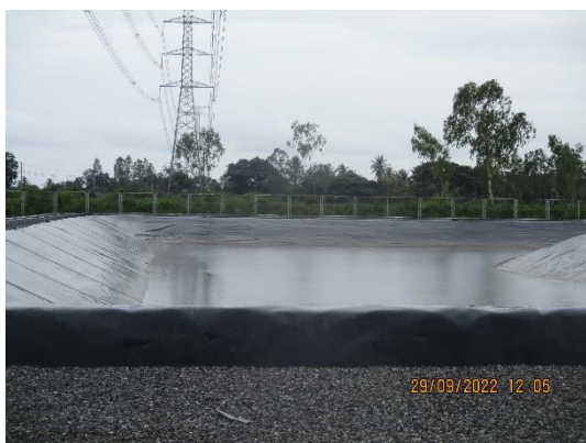
รูปที่ 22 บ่อท่วงน้ำฝนขนาด 13,600 ลูกบาศก์เมตร
