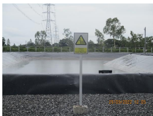
รูปที่ 22 บ่อท่วงน้ำฝนขนาด 13,600 ลูกบาศก์เมตร
