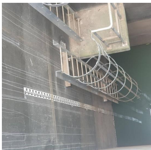
รูปที่ 21 อุปกรณ์แสดงระดับน้ำของแม่น้ำแม่กลองที่บริเวณสถานีสูบน้ำ
