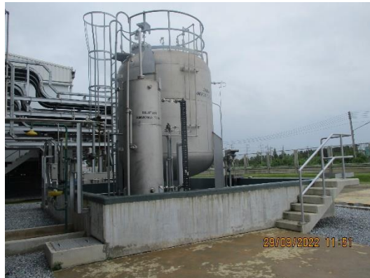
รูปที่ 41 ถังเก็บแอมโมเนียเหลว และกำแพงคอนกรีต (Dike)
