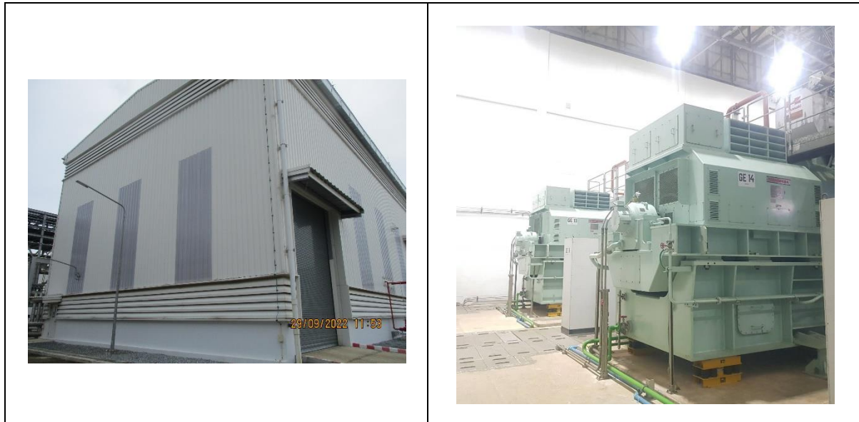
รูปที่ 6 อาคารกันเสียงบริเวณ Gas Engine Generator และลักษณะภายในอาคาร
