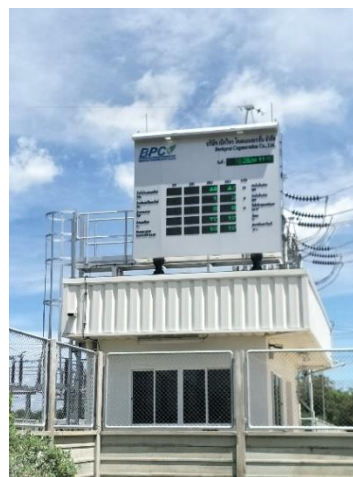
รูปที่ 2 จอแสดงผลการตรวจวัดคุณภาพอากาศจากปล่องบริเวณด้านหน้าโครงการ
